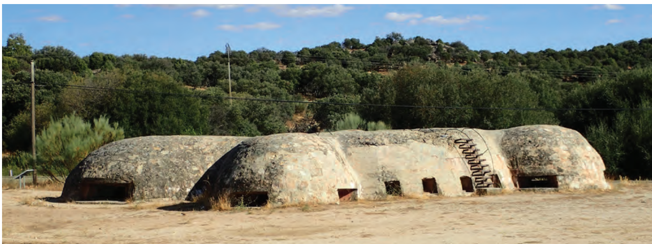
Figura 7. Blockhaus restaurado en la Comunidad de Madrid. El sitio ha sido acondicionado dentro del Plan Regional de Fortificaciones de la Guerra Civil (1936–1939) y se han colocado carteles que lo explican, sobre todo, desde la perspectiva de su tipología arquitectónica.
